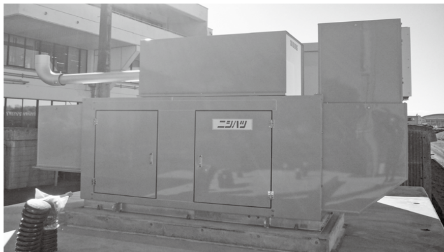
設置途中の非常用自家発電設備（事務局）
