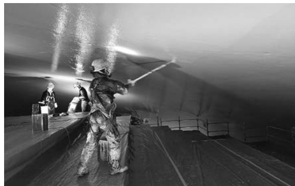
（内部）天井の塗装作業
