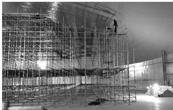
（内部）塗装作業のための足場
