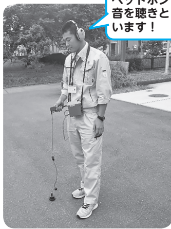
漏水調査の様子⇒
