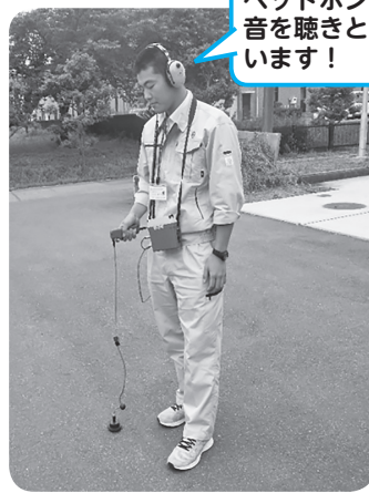
漏水調査の様子⇒
