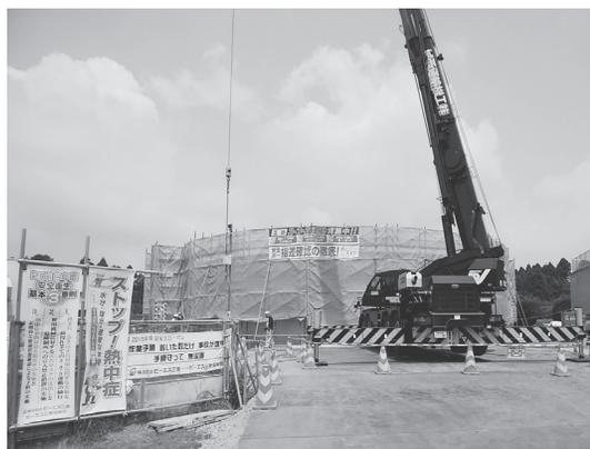
現在、山武水道では震災時にも安定した給水を行うため、松尾配水場に地震に強い『3号配水池』を築造しています。
